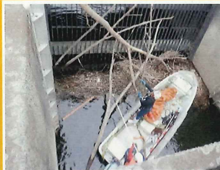
集塵機の流木等の撤去作業 (三郷市新和2丁目)
