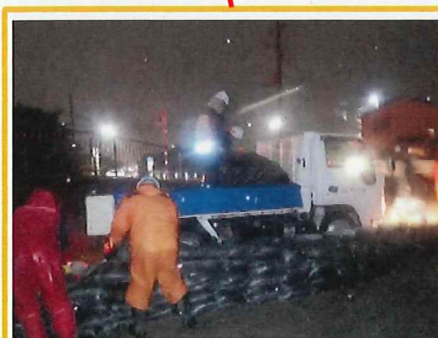
災害復旧資材の移送支援作業 (越谷市東町2丁目)
