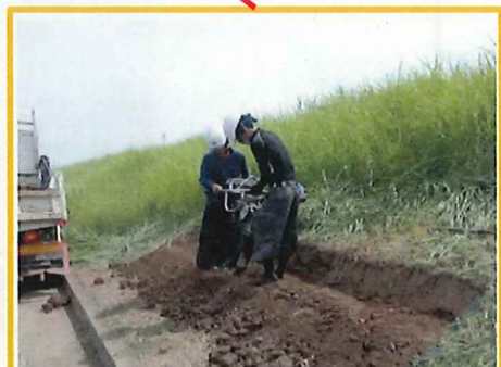
堤防法面崩れの緊急復旧作業 (八潮市木曾根)
