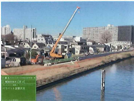
住宅近接部での施工
