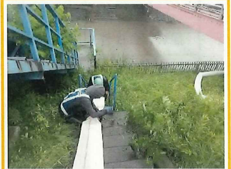
排水ポンプ車のホース設置作業 (三郷市新和2丁目)
