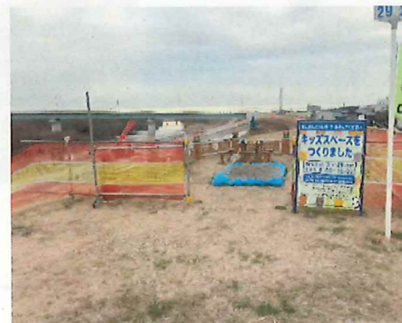
近隣住民休憩所・キッズスペース設置
