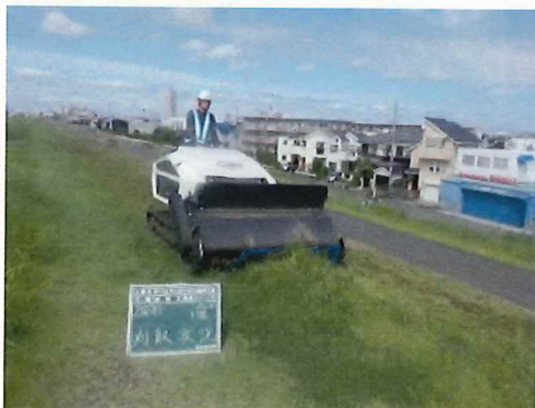
堤防除草施工状況
