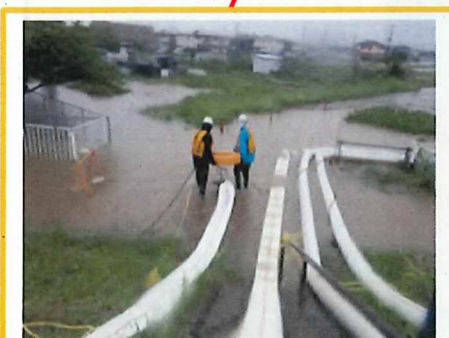
排水ポンプ車のホース設置作業 (松伏町松伏)
