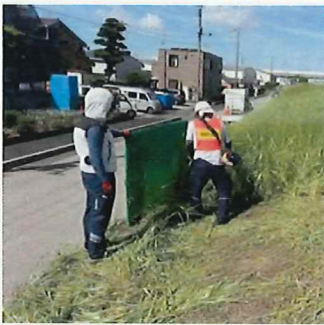
除草状況 (飛散防止対策)
