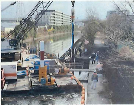
狭小な河道内での水上施工
