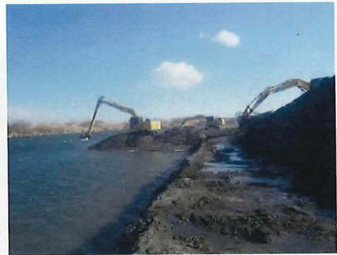
河床堆積土砂撤去施工状況
