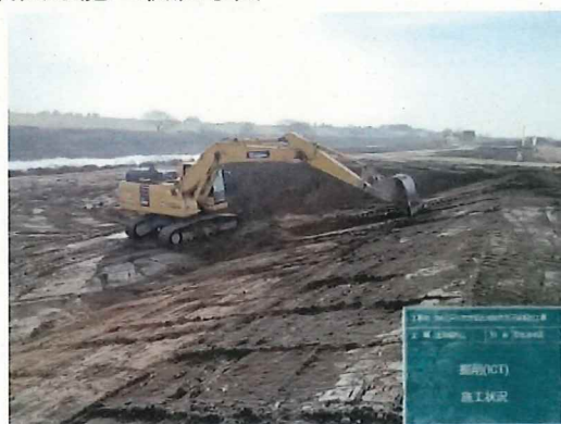
掘削工 施工状況
