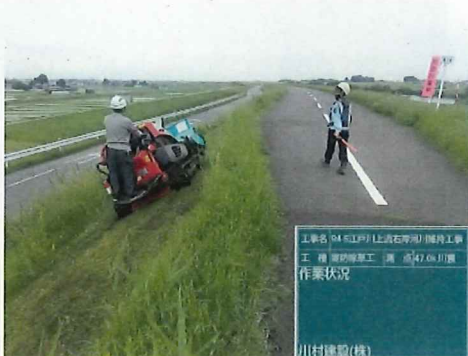
堤防除草施工状況
