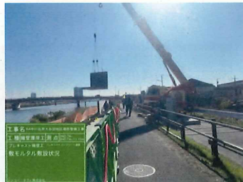
狭小な堤防天端での施工
