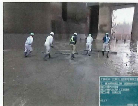
首都圏外郭放水路調圧水槽 土砂撤去施工状況
