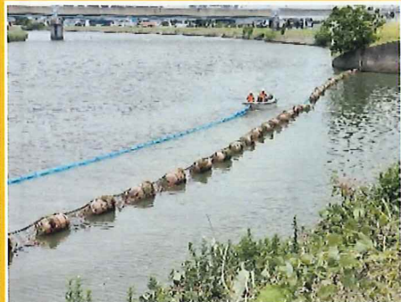
ゴミ流入防止フェンス設置作業 (三郷市新和1丁目)
