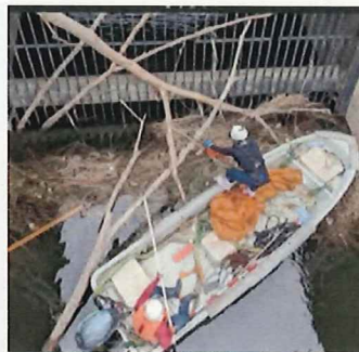
出水後の機場除塵機流木撤去状況
