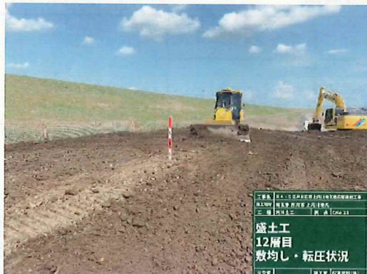
盛土の施工状況
