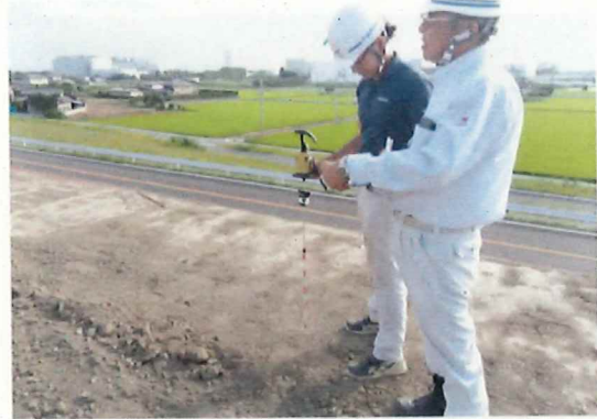
若手技術者による出来形確認
