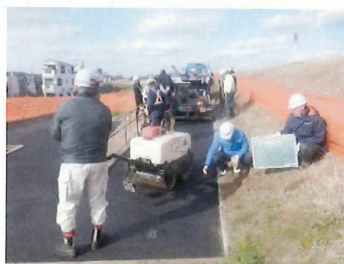
堤防坂路舗装施工状況
