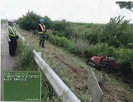
ラジコン式除草機械による急斜面の除草
